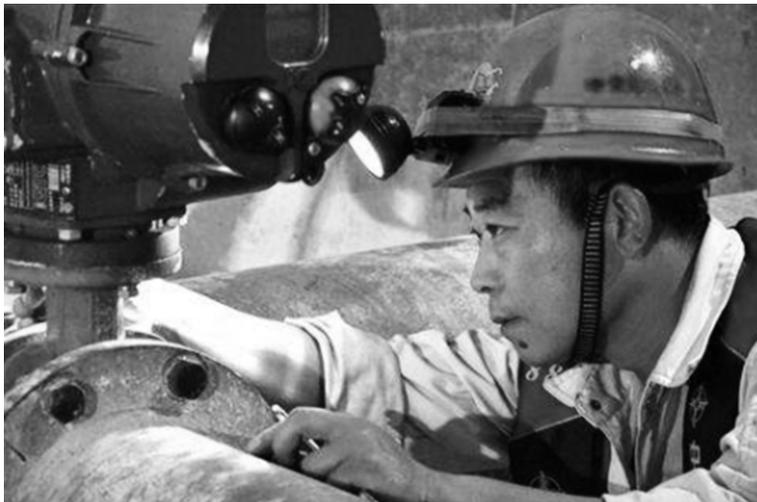
管延安的一项工作是负责安装沉管阀门螺丝。如果在陆地作业,只要拧紧螺丝就够了。但要在深海中完成两节沉管的精准对接,确保隧道不渗水不漏水,沉管接缝处的间隙必须小于1毫米。1毫米的间隙,根本无法用肉眼判断。可管延安硬是通过一次次拆卸练习,凭着“手感”创下了零缝隙的奇迹。为了找到这种“感觉”,他拧螺丝时从不戴手套,为的是有“手感”。经过数以万计次的重复磨炼,管延安练就了一项骄人的高精度绝技:左右手拧螺丝均实现误差不超过1毫米。
